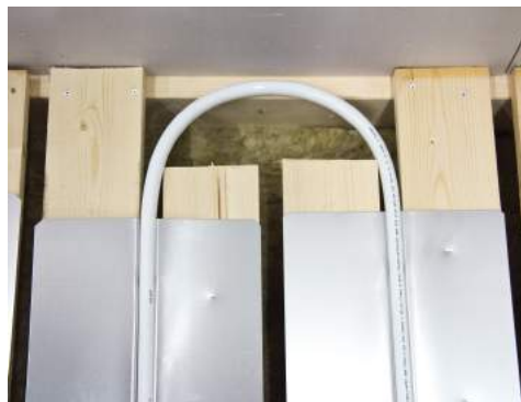
11. Exempel på korrekt vändning av röret.
