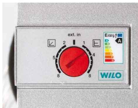
Bild 96: Justering av cirkulationspump
