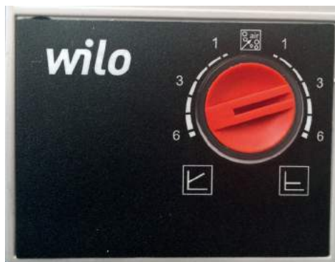
Bild 89: Justering av cirkulationspump
