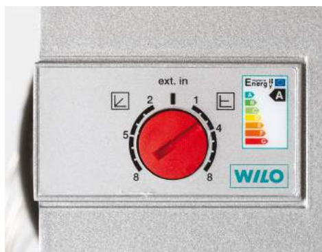
Bild 93: Justering av cirkulationspump
