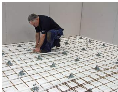
5. När röret är fäst i vändningarna går det lätt och snabbt att naja hela installationen.
