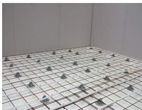
7. Täck rörens hjässa med minst 30 mm betong för att säkerhetsställa värmespridning.
