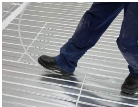
11. Rördragning i rakt spår.
