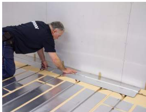
13. Montera plåtar även i matningsspåret.
