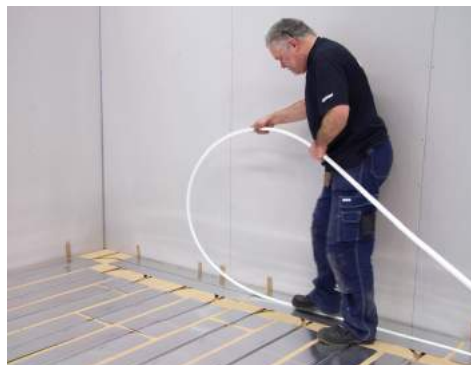
14. Montera golvvärmeröret.
