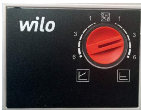
Bild 102: Justering av cirkulationspump
