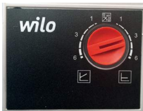
Bild 99: Justering av cirkulationspump
