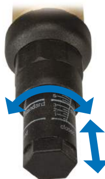
Bild 133: Förinställning av reglerventilen
