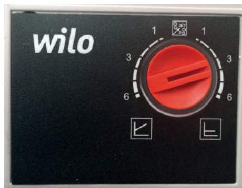
Bild 85: Justering av cirkulationspump
