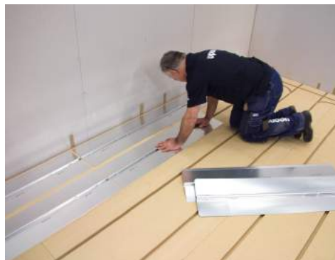
12. Montera plåtarna med minst 10 mm och max 100 mm mellanrum. Plåtarna kan enkelt delas vid knäckanvisningarna. Använd gärna överbliven plåt från första spåret i nästa spår för att minimera spillet.
